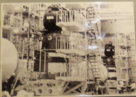
Монтажно-испытательный вертел, корпус «Соез». Космодром «Байконур». Монтаж космической ракеты ракетного управления «Прокатмонтаж», 1965 г.
